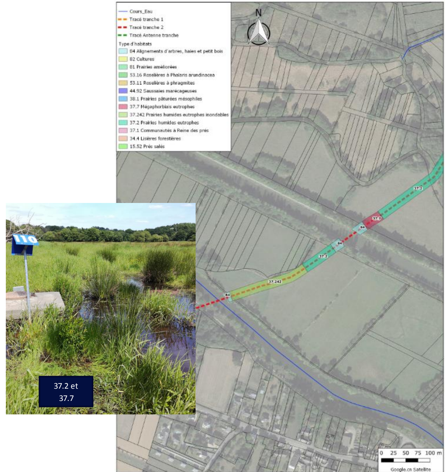
Figure 19 : Site 3 après impact (partie 1)
